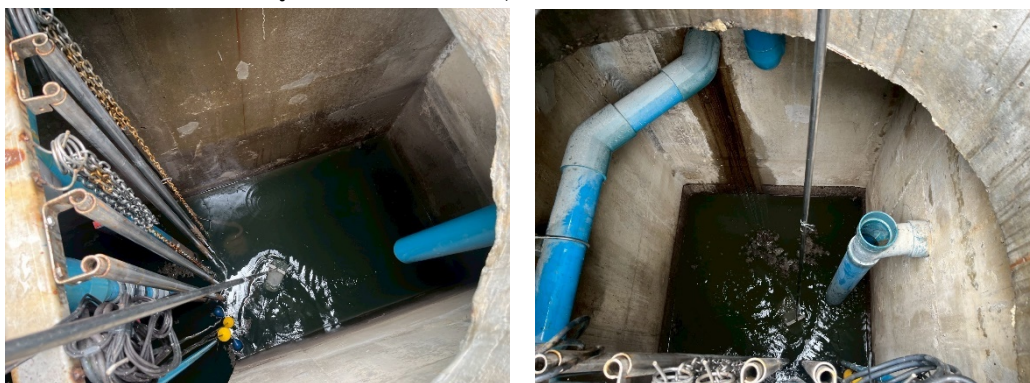
จุดที่ 1 บริเวณถังปรับสภาพสมดุลของระบบบำบัดน้ำเสียอาคาร A
